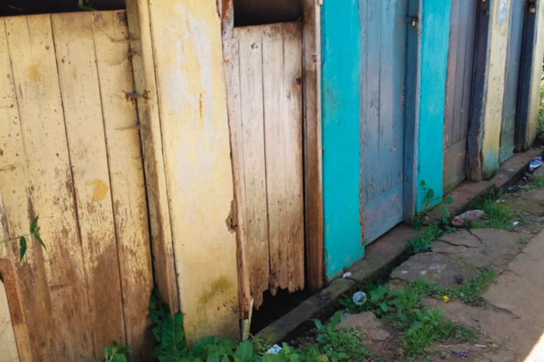
Työntekijöiden perheiden käymälät sijaitsevat erillisissä rakennuksissa lyhyen matkan päässä työntekijöiden linjahuoneista. Kuva on Pedro-plantaasilta.
